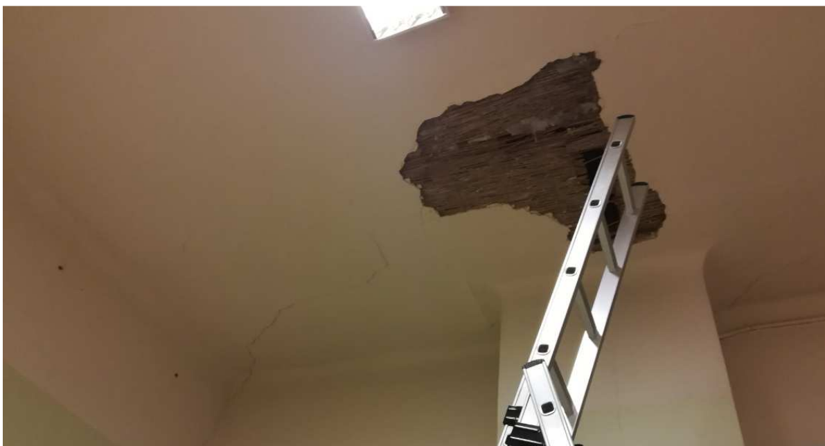
foto 4 – strop učebny v 2.NP – trhlina, sonda a komín
