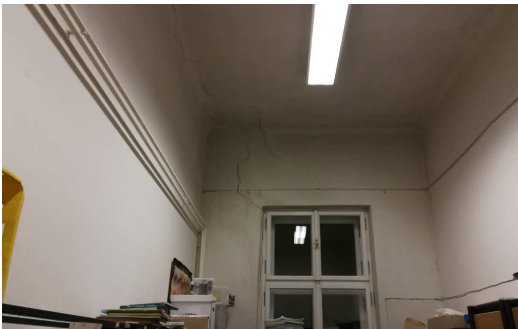
foto 6 – kabinet – trhliny
